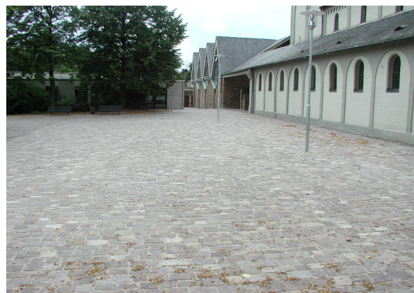
5. Fertig verfugte Fläche
