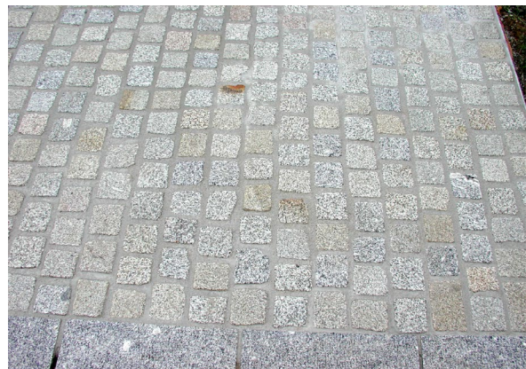
5. Fertig verfugte Fläche
