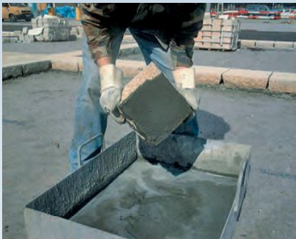
Bild 6: Granitplatte mit Kontaktschlämme für optimalen Verbund zum Bettungsmörtel
