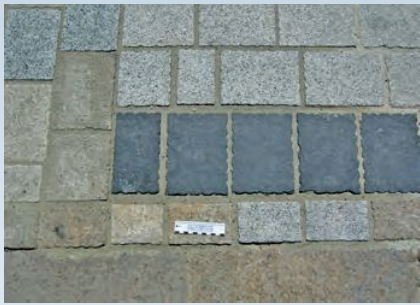
Bild 4: Bielefeld, Rathausstraße. Detailaufnahme Großpflaster mit Pflasterfugenmörtel
