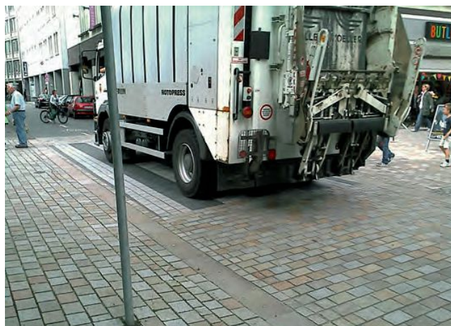
Bild 1: Ver- und Entsorgungsfahrzeuge im Innenstadtbereich von Bielefeld, Rathausstraße mit Großpflaster Granit auf Dränbetontragschicht. Aufbau: Dränbetontragschicht, Dränfeinbeton, 14 cm Granitpflaster, vollfugig verfugt mit zementgebundenem Pflasterfugenmörtel
