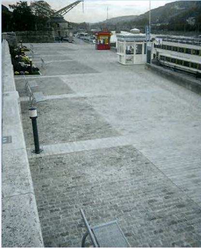
Bild 2: Würzburg, Schiffsanleger am Kranenkai. Kalksteingroßpflaster in gebundener Bauweise
